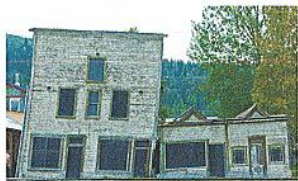
FIGURE 3 > L'affaissement de bâtiments est une des conséquences du dégel du pergélisol.
