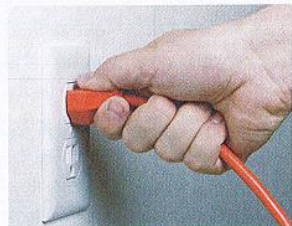
FIGURE 5 > La gaine qui entoure les fils électriques permet de les manipuler en toute sécurité.
