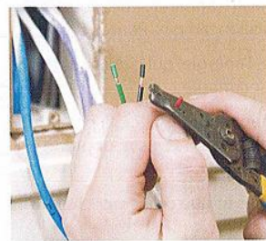
FIGURE 6 > Pour brancher deux fils électriques ensemble, il faut d'abord retirer la gaine isolante qui les recouvre. Aucun courant ne doit circuler dans les fils durant cette opération.
